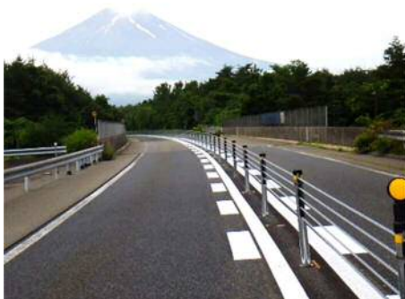
ワイヤーロープ式防護柵を 設置しました
