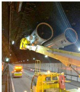
トンネル内のジェット ファンを点検しました。
