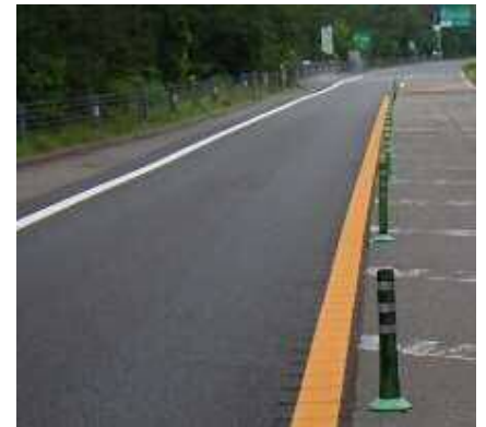
傷んだ路面を補修しました
